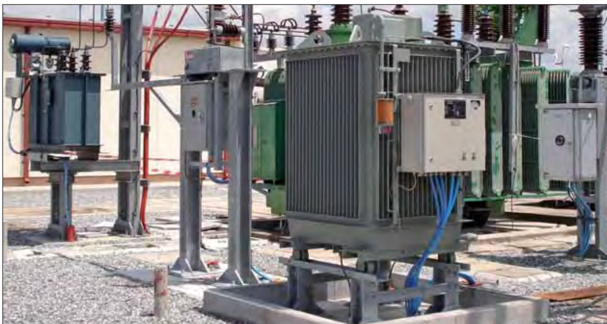
Рис. 3: Реактор 10 кВ
