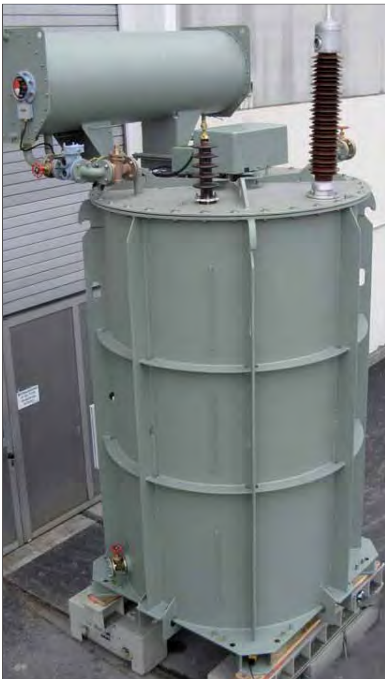
Рис. 4: 110/√3 кВ, 8000 кВАр, продолжительный режим работы
